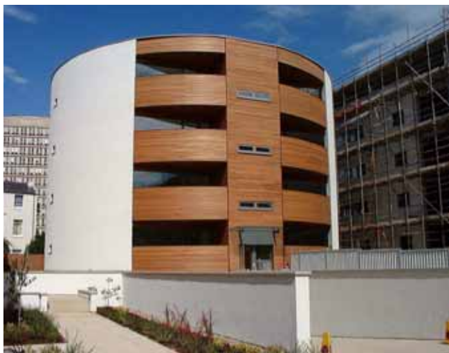
Nová budova soudu v Londýně, vystavěná s použitím výrazného podílu certifikovaného dřeva
